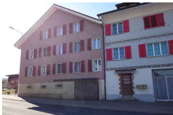
Gebäude auf Parz. Nrn. 130, 129
