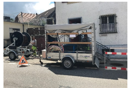
Bau des Glasfasernetzes: Einblasen der Glasfasern am Knotenpunkt in Luthern
