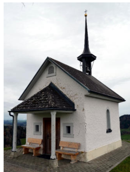
Heubergkapelle erhält eine Aussenrenovation
