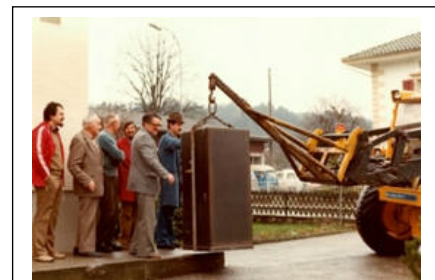
Bankneubau 1983 mit Umzug Tresor
