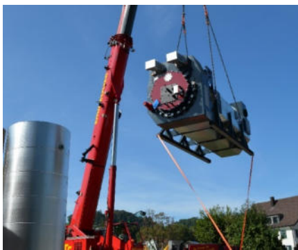
22 Tonnen am Kran
