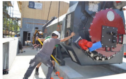
Letzte Arbeiten beim Platzieren
