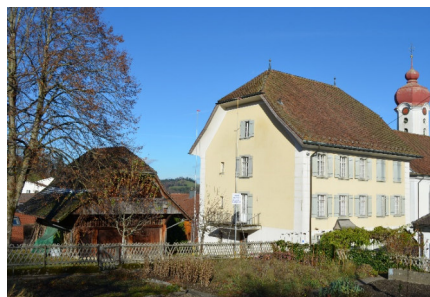
An der Pfarrhaus Rückseite sollen Balkone und Lift angebaut werden
